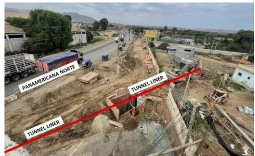
Vista aérea: Tunnel Liner cruzando Panamericana Norte
