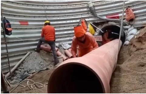
Excavación manual dentro del tunnel liner
