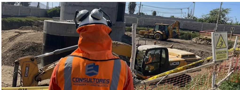
Equipo profesional en inspección de tunnel liner terminado
